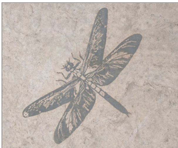
Фигура 5. Бетонно изображение, постигнато чрез използване на гелирана киселина от Surface Gel Tek 14
